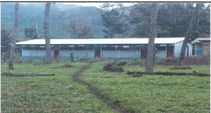
Foto 4: El cerco perimetral muestra que requiere sustitucion
